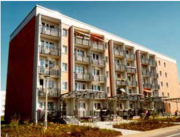
Ohrdruf / Thüringen: Vorgehängte Keramik-Fassade EURACON KH-610
