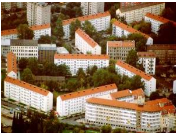
2000: Von BRF sanierte Wilsdruffer Vorstadt in Dresden
