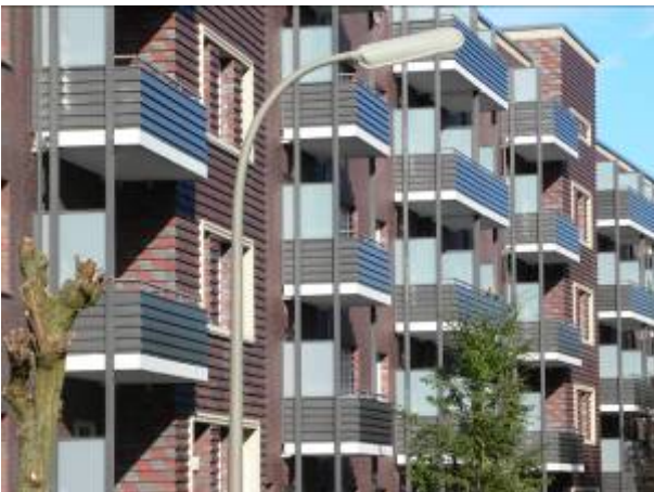
Hamburg: Wärmedämmfassade mit keramischer Oberfläche und Stahl-Beton-Balkone von Euracon
